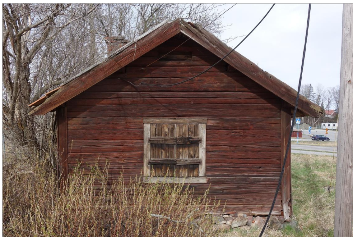
Södra gaveln med fönstret till tvättstugan.
