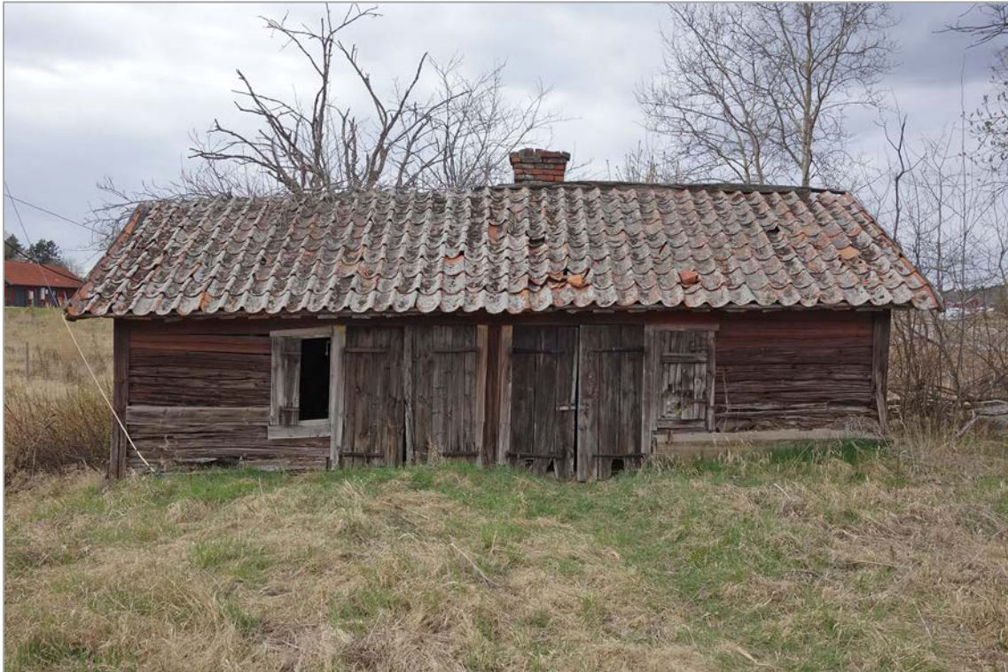
Huset sett från sydost med porten och fönstret till tvättstugan till vänster och dito till smedjan till höger.
