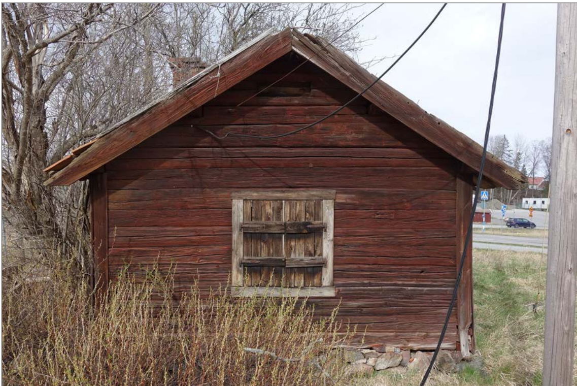
Södra gaveln med fönstret till tvättstugan.
