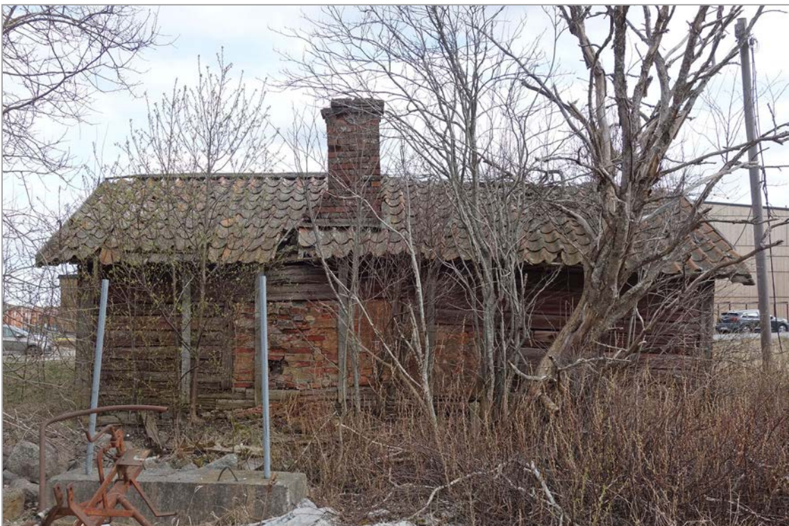
Huset sett från baksidan i nordväst. Bakom all sly syns att delar av väggen utgörs av den murade ässjan och pannmuren.
